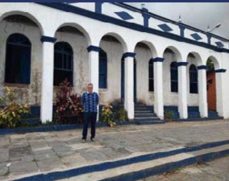
Foto atual com a restauração parcial da Casa do Morro. Fonte: Leandro de Marque. nov 2018.
