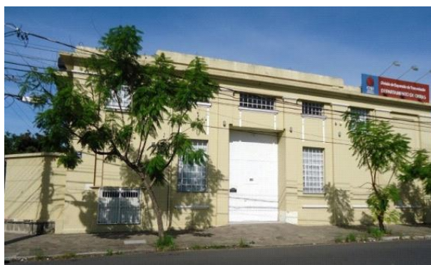
Figura 8 Usina de emergência da CEEE, na Av. São Paulo esquina Rua Ernesto Fontoura, prédio bem conservado. Fonte: Acervo familiar
