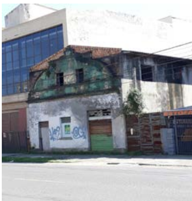
Figura 2. Vista frontal da Sede da Federação Operaria do Rio Grande do Sul
