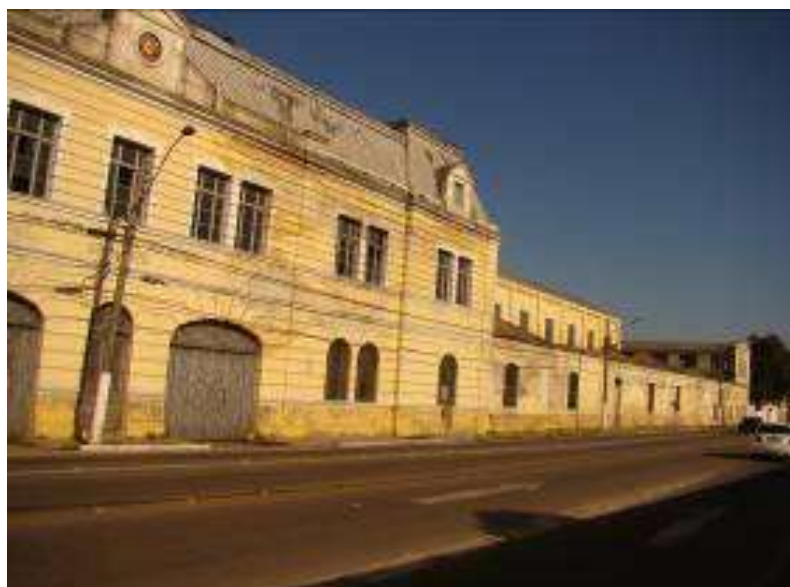
Figura 4 – Fachada principal. Fonte: Acervo Rogério Piva.
