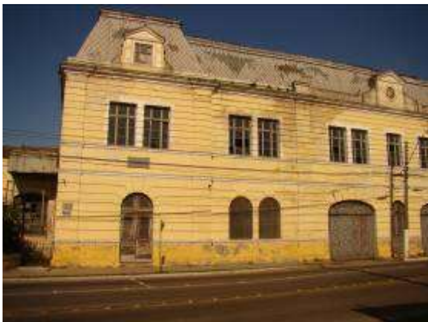
Figura 5 – Fachada principal. Fonte: Acervo Rogério Piva.
