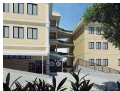
Expansão do Bloco B
